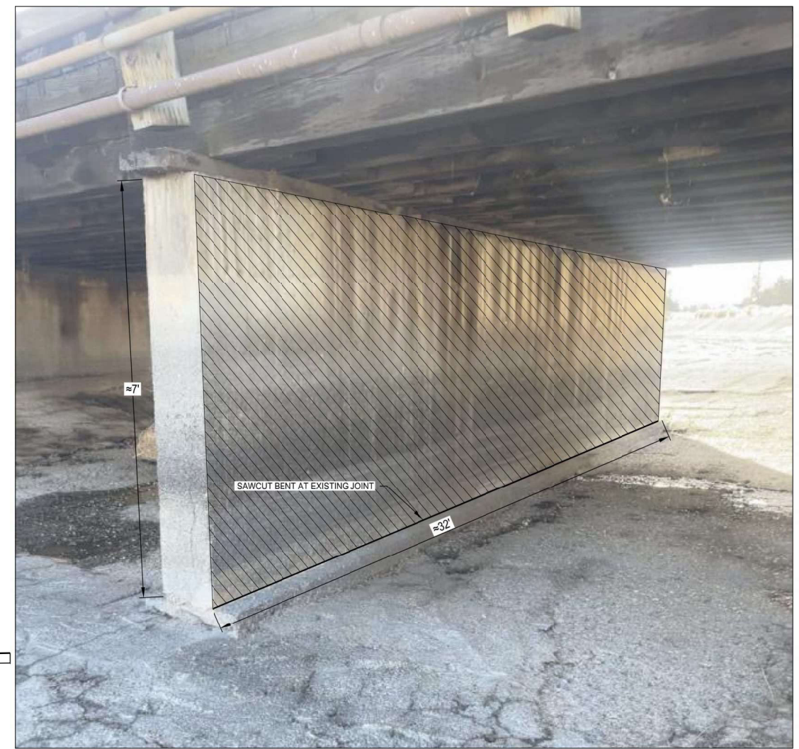
CENTER BENT REMOVAL N.T.S.
